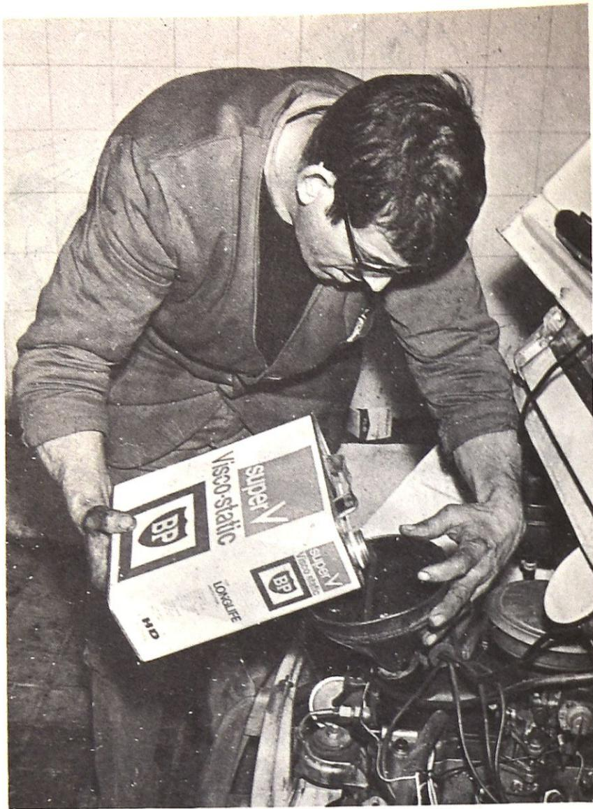
Con un buen embudo, y la varilla del nivel sacada, no hay peligro de que el aceite reboque y manche el motor.
