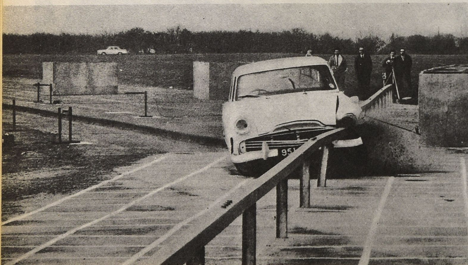
Prueba de un pretil de autopistas experimental de perfil rectangular hueco. Velocidad del vehículo: 87 km/h. Angulo de impacto: 20°
