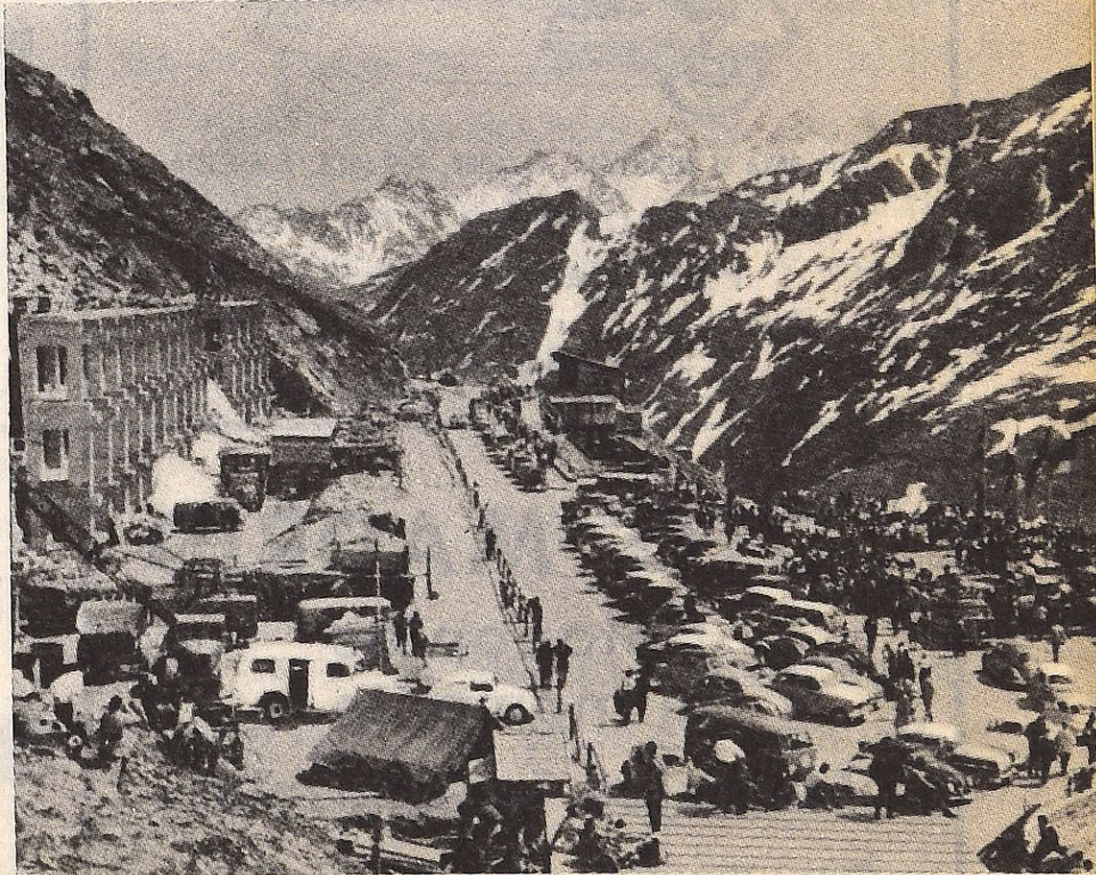
Garage de cinco pisos que se construye actualmente en el punto más alto del "col", adosado al muro de roca, y que será capaz para 900 coches y 300 motos.
