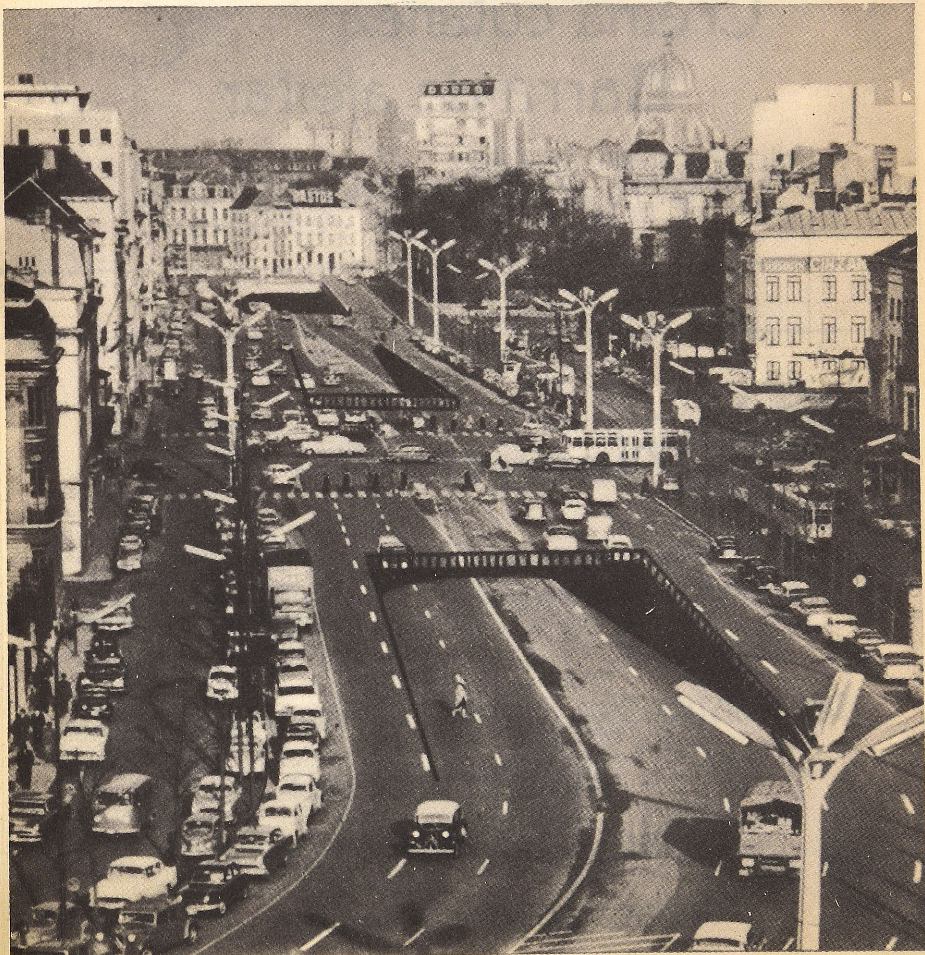
EJE DE LOS BULEVARES DE BRUSELAS Y TRAZADO APROXIMADO DEL TUNEL EN CONSTRUCCION PARA DESCONGESTIONAR EL TRAFICO
