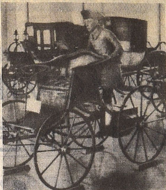
Un auténtico precursor del automóvil —la silla de pedales de 1780— que figura en el Museo de Munich. En él los pies del hombre no tocan el suelo pero actuaban sobre unas ruedas motrices. Un lacayo, apoyándose alternativamente sobre dos planchas, servía de motor. Aquel vehículo autónomo, no remolcado, poseía ya una dirección mandada por el personaje transportado.
