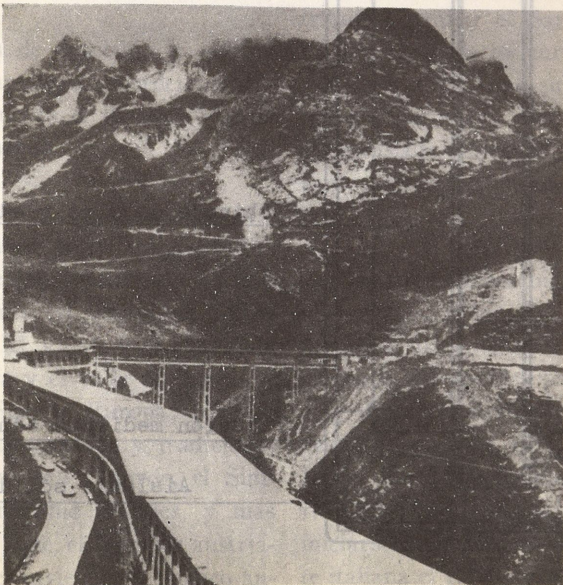
La carretera cubierta de acceso al túnel, por el lado italiano.
