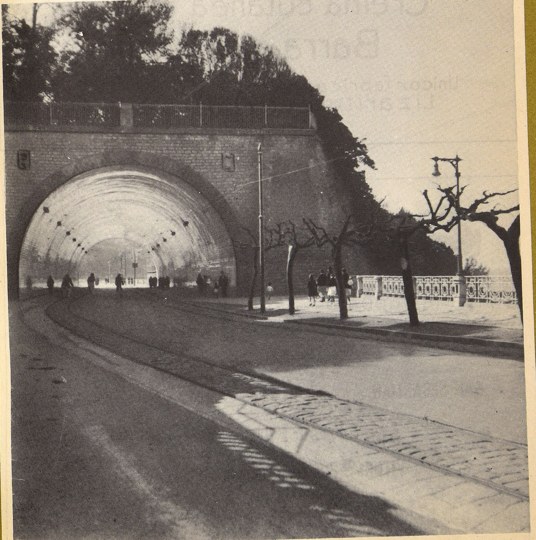
ENTRADA DEL TUNEL DEL ANTIGUO DURANTE UN LUMINOSO MEDIODIA DE PRIMAVERA. (Foto, Marqués de Santa María del Villar)
