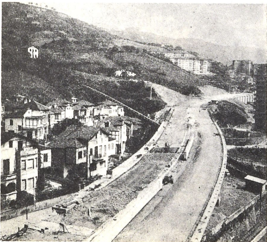
Viaducto sobre el funicular de Archanda
