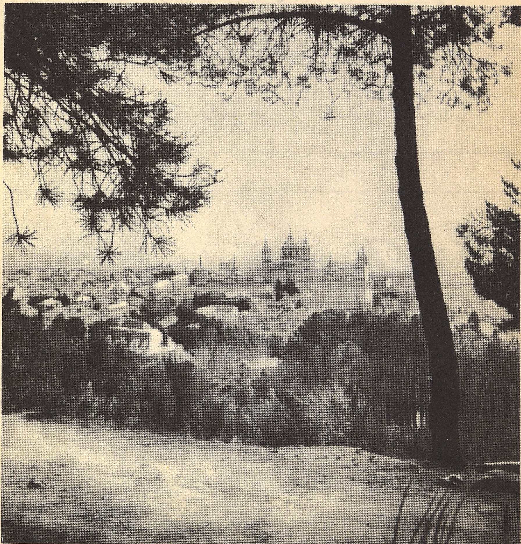
EL MONASTERIO DE EL ESCORIAL, CONTEMPLADO DESDE UN LUGAR DE LA CARRETERA VILLALBA-AVILA EN CONSTRUCCION
