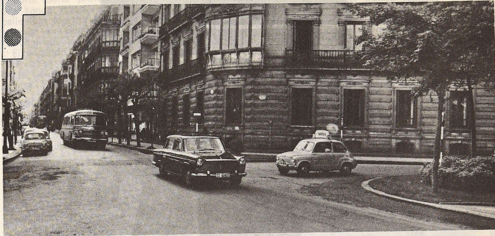
En la bifurcación del Paseo de los Fueros con la calle San Martín se hace precisa la instalación de un semáforo. (Foto: Aygüés)
